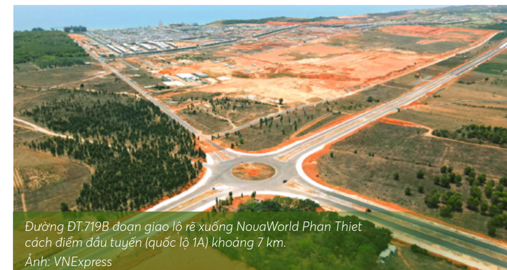
Một đoạn đường ven biển DT.719B
