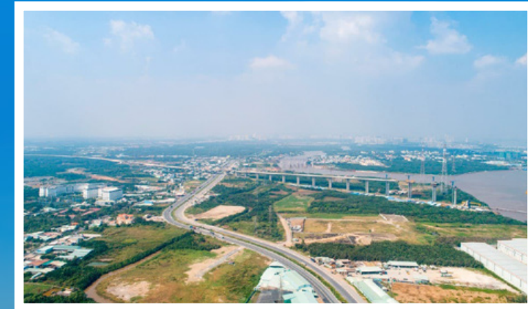
Cao tốc Bến Lức – Long Thành dự kiến hoàn thành trong năm 2024. Nguồn ảnh: Tạp chí Thương trường
