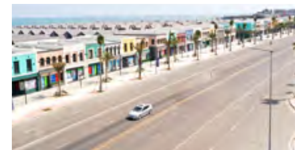
Chuỗi shophouse đại lộ Sunny tại phân kỳ The Tropicana, dự án NovaWorld Ho Tram (Bà Rịa, Vũng Tàu)
