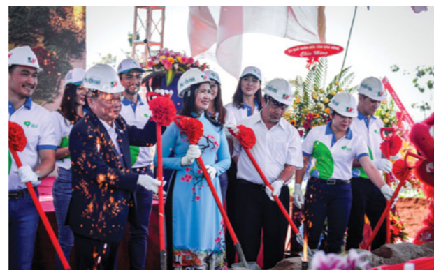
Lễ khởi công xây dựng trường tiểu học Hiếu về trái tim Đắc Nông vào tháng 05/2018
