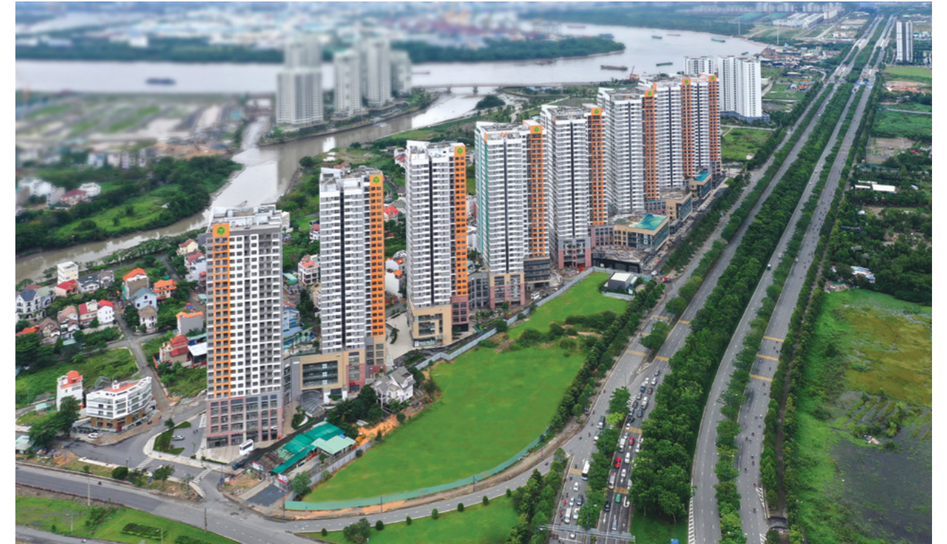
Công trình The Sun Avenue (Q.2)
