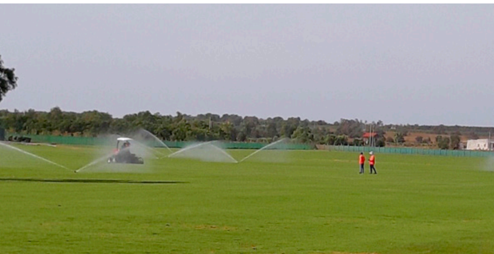
Cụm sân Golf 36 lỗ đã hoàn thiện phần san lấp mặt bằng và cải tạo địa hình sân. Dự kiến hoàn thành Quý IV/2020
