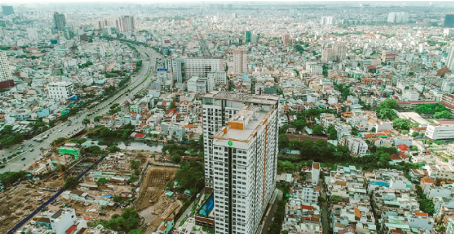
Wilton Tower (Q. Bình Thạnh) đã hoàn thiện
