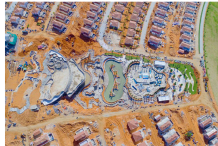
Khu công viên nước trung tâm đạt tiến độ 85% và đang trong quá trình hoàn thiện, lắp đặt các thiết bị trò chơi giải trí, thuyền cướp biển,... Dự kiến hoàn thành quý 1/2021
