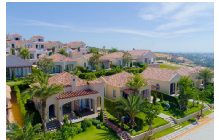
Khu biệt thự NH2, NH5, NH6 đang trong quá trình hoàn thiện nội thất, cảnh quan, cây xanh và dự kiến bàn giao từ tháng 02/2021
