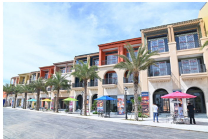
19 căn shophouse (nhà phố thương mại) biến đổi diện công viên Bikini Beach đã được bàn giao vào tháng 1/2021 và chuẩn bị chuẩn bị vận hành
