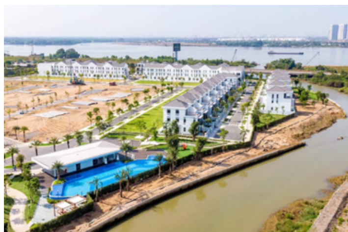
Đại công trường Aqua City được thi công ngày đêm để đảm bảo hoàn thiện theo đúng tiến độ
