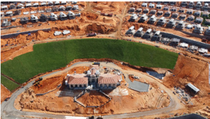
Khu Welcome Center đã thi công được 80%, dự kiến sẽ đón khách tham quan vào tháng 09/2020.
