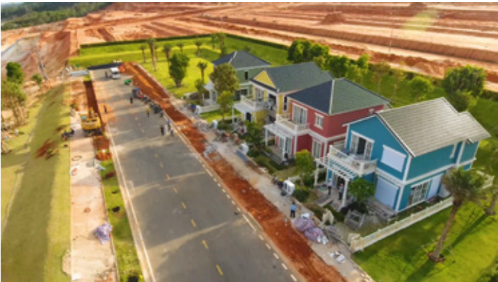
Khu biệt thự mẫu được thiết kế theo phong cách kiến trúc Floria và đã hoàn thiện được 90% và dự kiến sẽ được khai trương đón khách tham quan vào tháng 09/2020.
