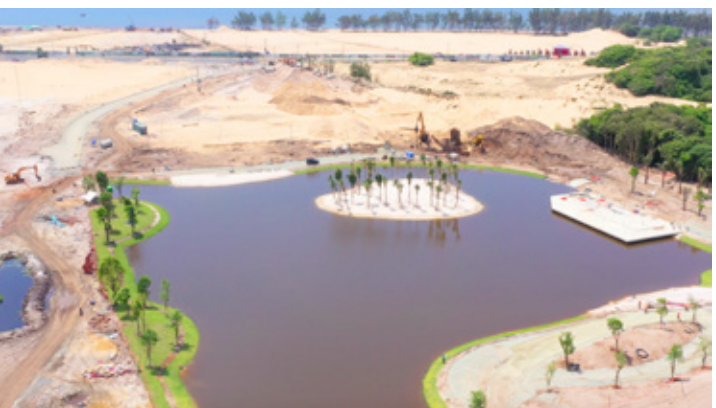
Công tác san nền, đào lấp toàn khu đã hoàn thành khoảng 85%.
