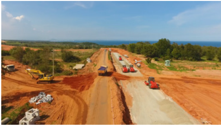
Đường Hòn Giổ - tuyến đường trung tâm với các công trình tiện ích chính, kết nối từ đường ven biển ra cao tốc Phan Thiết - Dầu Giây đã hoàn thiện được 50%.
